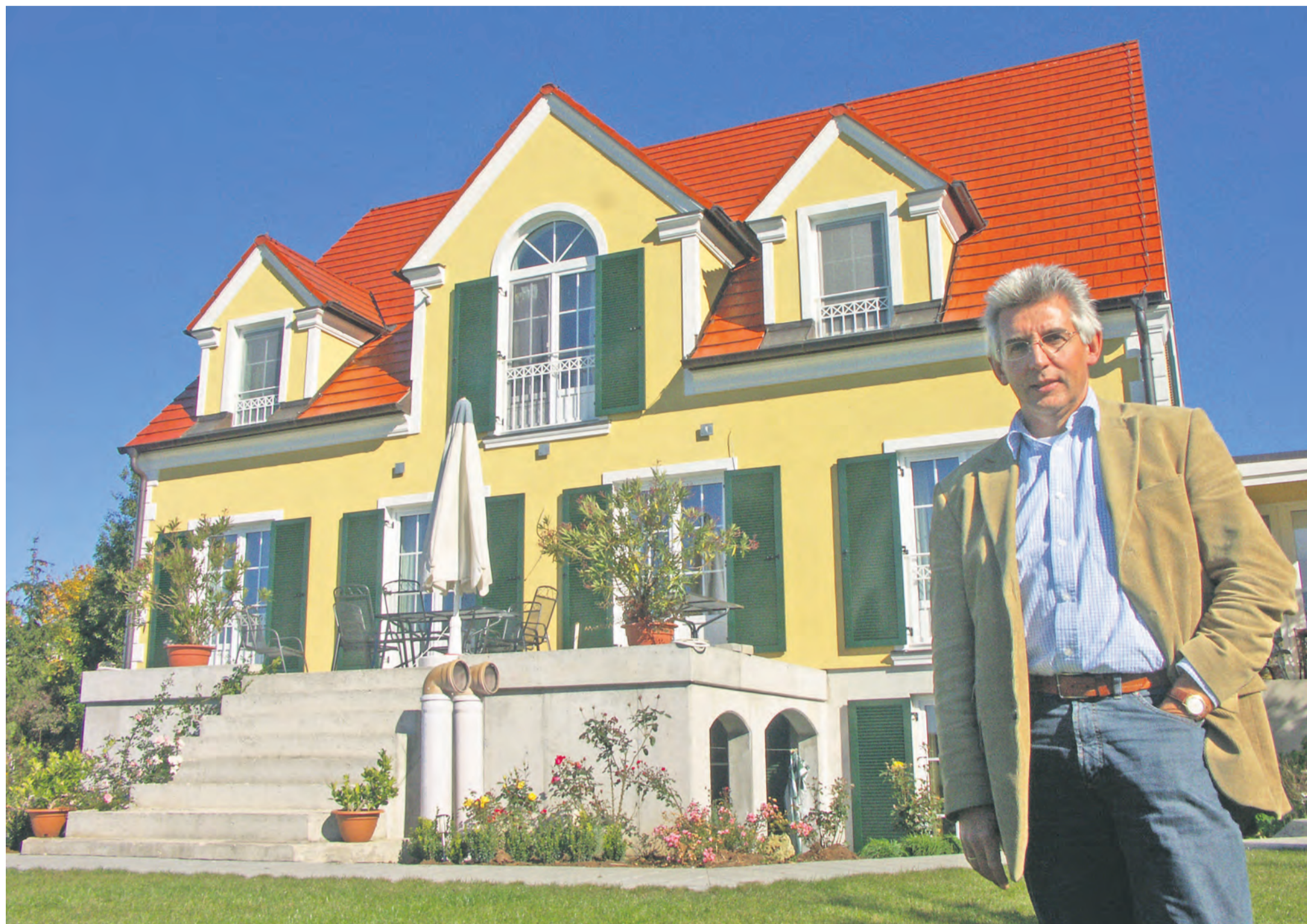
Sparen in Schwaben: Umgerechnet nur 450 Liter Heizöl braucht Leonhard Taglieber für seine 300 Quadratmeter Wohnfläche – dank Passivhaus und Wärmepumpentechnik.
